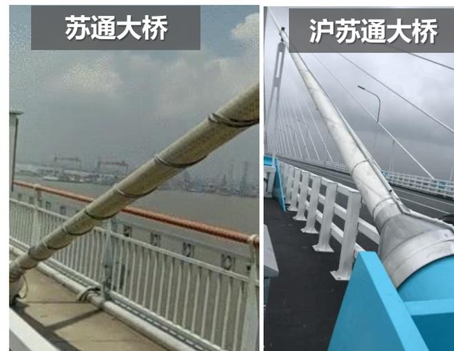
斜拉索高阶涡激振动
