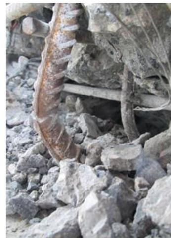
(d) 东侧纵筋断裂
